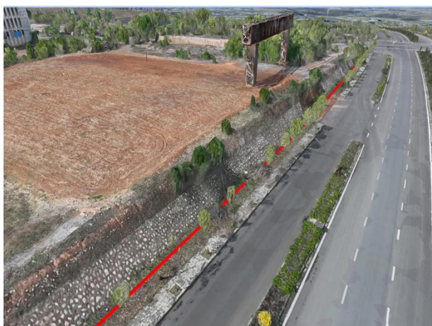
管线沿五西线铺设现状
