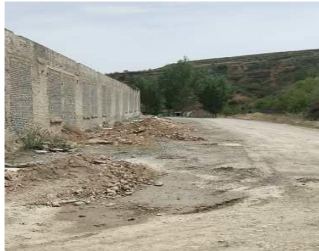
厂区东南侧现状
