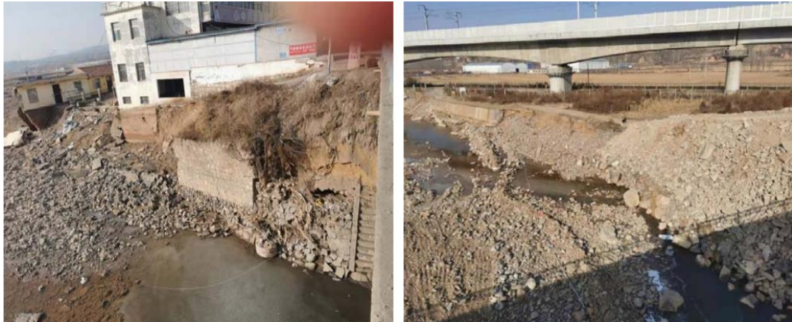
图 5 西营大桥现状图
