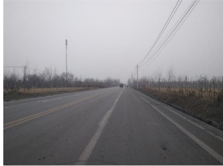
县城二水厂西侧公路
