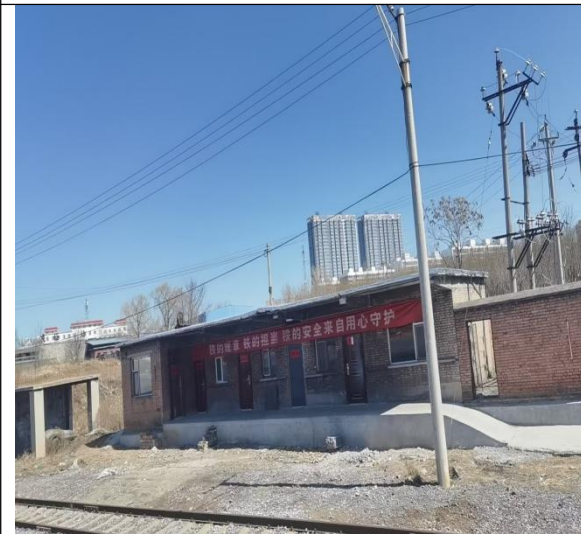
厂区东侧原有建筑
